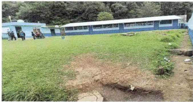
Foto 1: Pintura en muros exteriores e interiores
