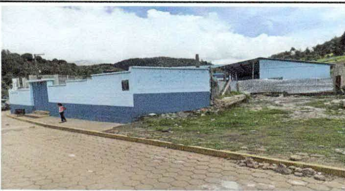
Foto 3: Pintura en muros exteriores e interiores
