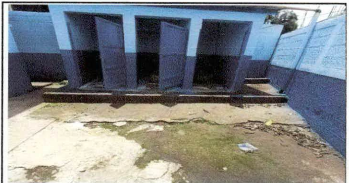
Foto 4: Pintura en muros exteriores e interiores
