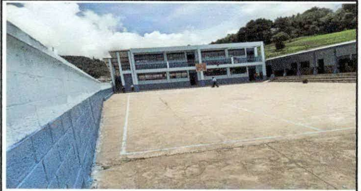
Foto 2: Pintura en muros exteriores e interiores
