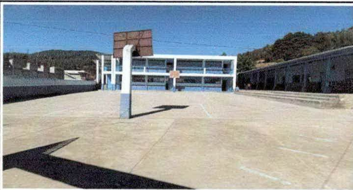
Foto 3: Pintura en muros exteriores e interiores
