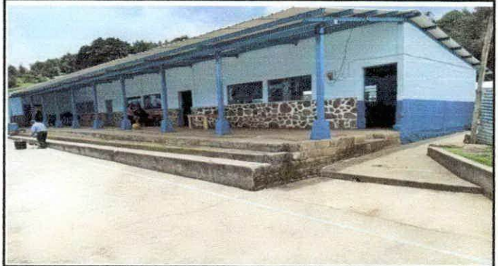
Foto 2: Pintura en muros exteriores e interiores
