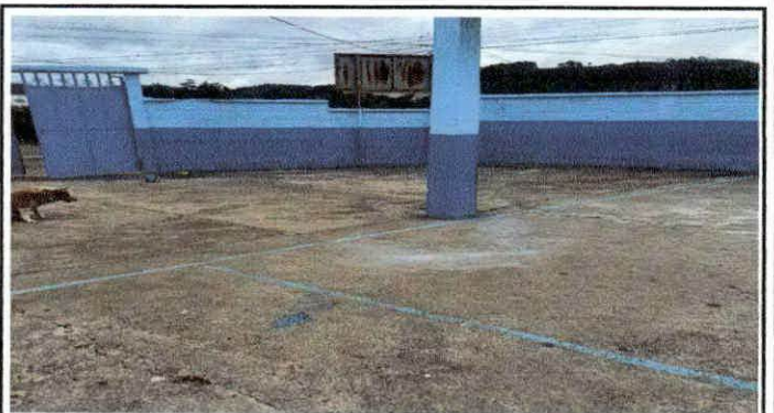
Foto 4: Pintura en muros exteriores e interiores
